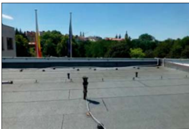
Obr. 7.2.a: Pohled na střechu magistrátu Hradce Králové, která je pokryta asfaltem
